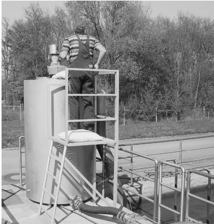
Abbildung 3: Nachfüllen des Dolomitreaktors in Bühl-Vimbuch
